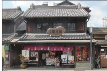
岩崎家・旧 醸建築研究所事務所
