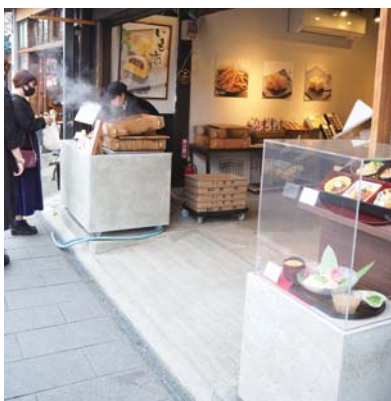
右門(幸町1-6)の入口部の改修
