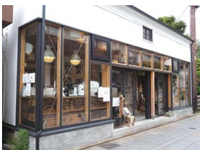
山屋 土蔵付属屋の改修
