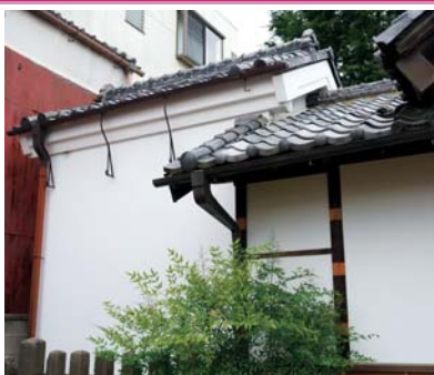
薬師神社の外壁の塗替え
