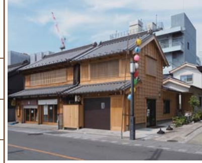
「天あさテナント棟」の建設
