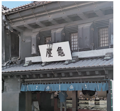
↑亀屋本店 下屋修理・看板取り換え
