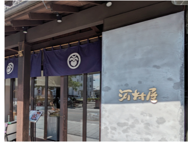
↑河村屋 改修工事
