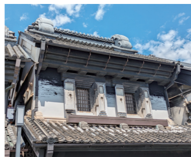
↑宮岡家まちかん 観音扉修理・外壁修理
