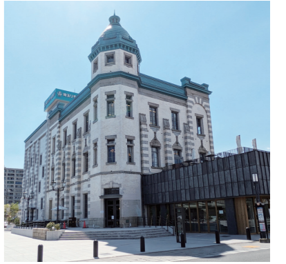
↑埼玉りそな銀行旧川越支店耐震化等工事
