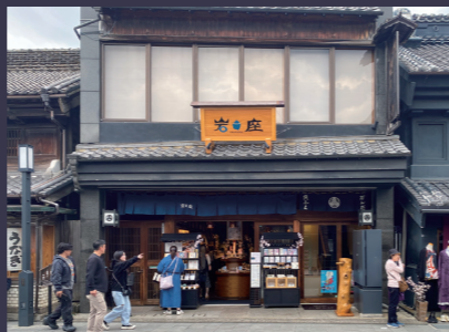
↑岩座ファサード工事
