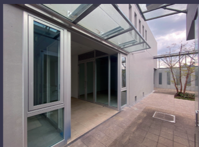
↑Fギャラリー改修工事
